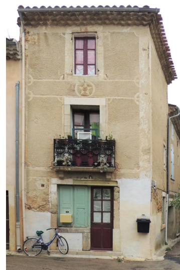
Décors géométriques de teinte claire lissés sur enduit à la tyrolienne, marquant chaîne d'angle, bandeaux horizontaux et verticaux
