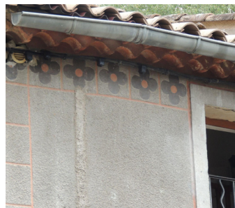
Décor géométrique encadrant la façade et motifs à fleur sous génoises
