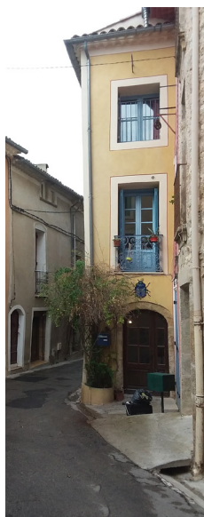
Bandeaux de teinte claire encadrants la façade et les baies, cernés par un filet rouge-brun
