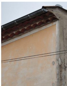
Bandeaux de teinte claire encadrants la façade, cernés par un filet sombre
