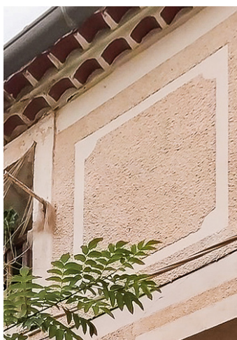
À la tyrolienne sur enduit taloché
