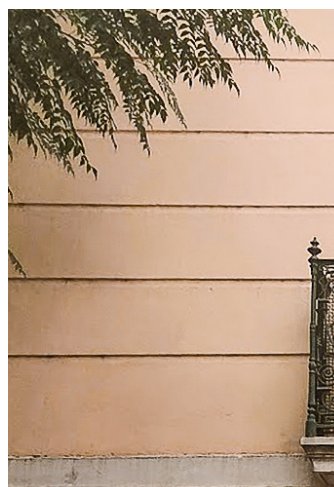
À joints creux
