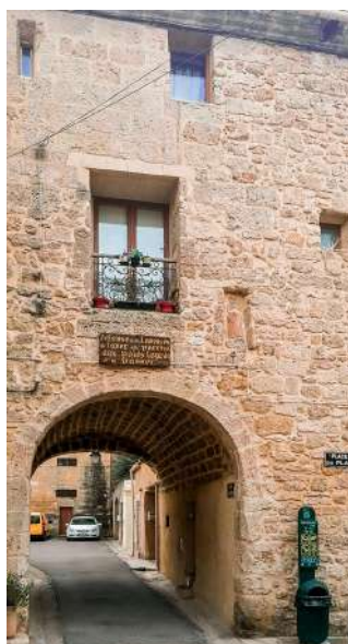
Paroi en moellons à pierres vues
