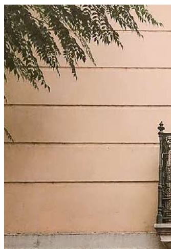
À joints creux
