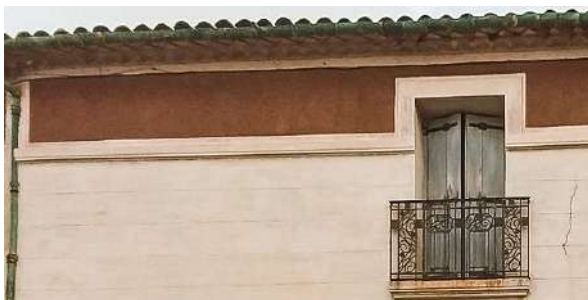
Bandeau large et coloré sous génoises avec enduit à la tyrolienne
