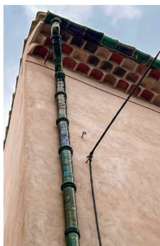
Chéneau et descente en céramique vernissée
