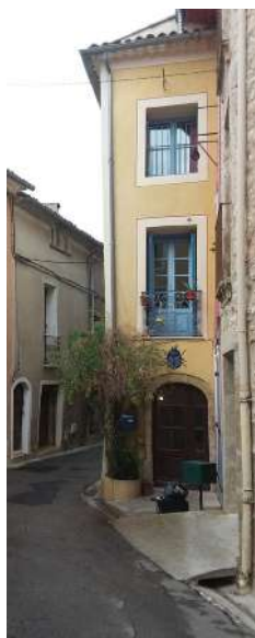
Bandeaux de teinte claire encadrants la façade et les baies, cernés par un filet rouge-brun
