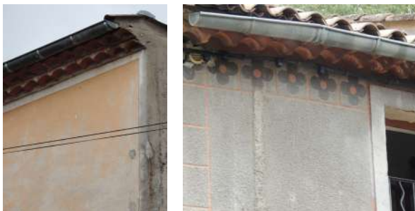
Bandeaux de teinte claire encadrants la façade, cernés par un filet sombre
