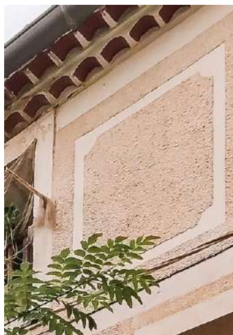
À la tyrolienne sur enduit taloché
