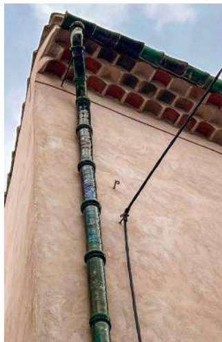
Chéneau et descente en céramique vernissée
