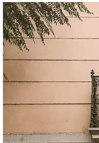
À joints creux
