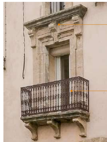
Encadrement de baie en pierre avec moulures+dessins et linteaux retombant
