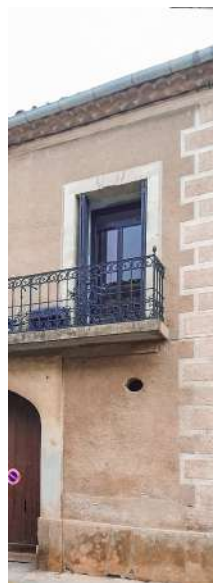
Décors géométriques de teinte claire lissés sur enduit à la tyrolienne, marquant chaîne d'angle, bandeaux horizontaux et verticaux
