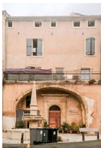
Paroi avec enduit et/ou badigeon
