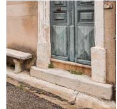
Seuil et marche en retrait du caniveau, en calcaire dur
