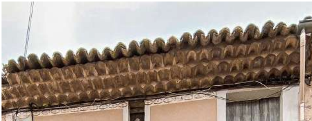
Génoises à plusieurs rangs de tuiles (sans parefeuilles)
