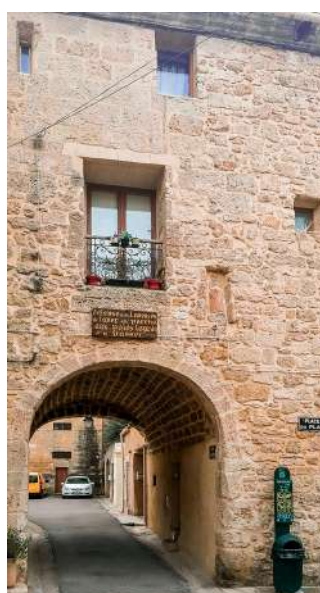
Paroi en moellons à pierres vues
